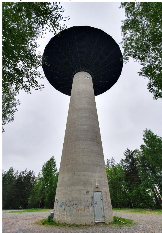
Lokakuun 2023 vesikriisin aiheuttajiksi epäiltiin muun muassa vesitornissa oleilevia naakkoja. Kuva: Jukka Tauriainen
